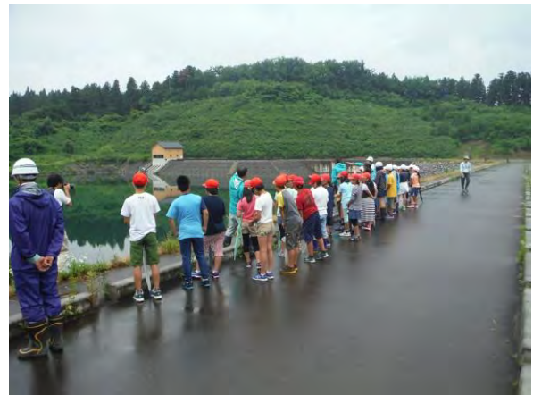
ダムの堤体より見学
