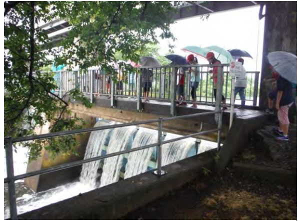
ゲートが下がって取水している状況
