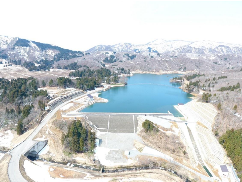
平成 31 年 3 月 29 日時点 (試験湛水中 (満水))
