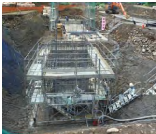
呑口水槽工の施工状況
