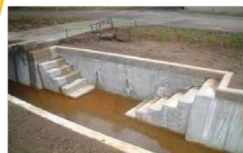
洗い場の改修
