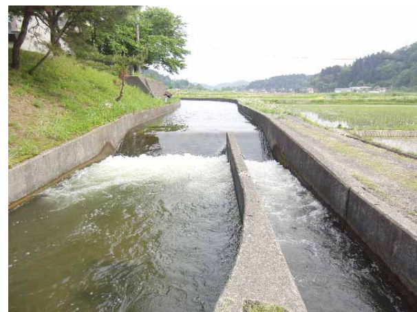
検討箇所のうち善根頭首工(分水工付近)
