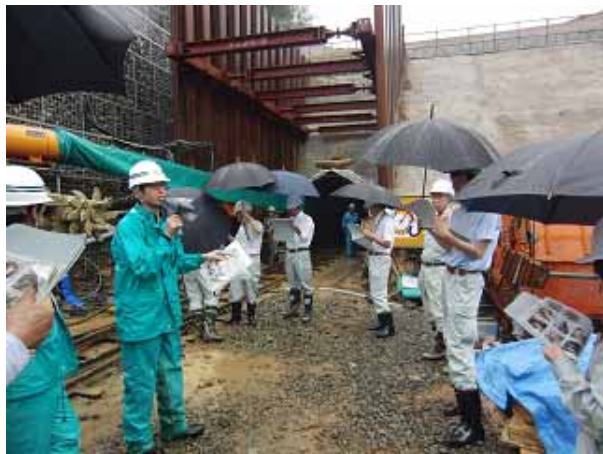
掘削中の仮排水トンネルの前で説明
