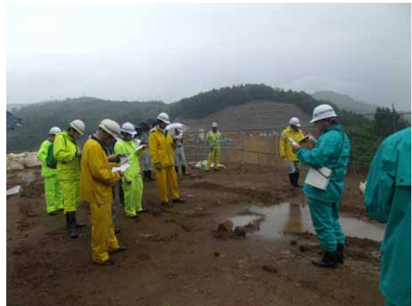
基礎処理試験ヤードにて説明をする井守係長
