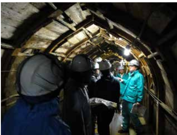
仮排水トンネルの中での貴重な説明
