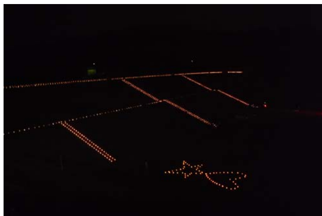
ダム堤体の輪郭が浮かび上がります
