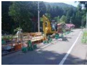
工事の様子(国道工区)
