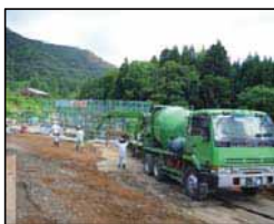
調圧水槽工事（コンクリート打設） 林道工区（路面排水工）
