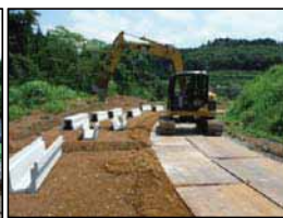
調圧水槽工事（コンクリート打設） 林道工区（路面排水工）
