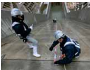
洪水吐の出来形検査
