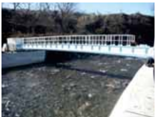
水管橋の架設後
