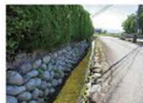
石積み水路の保全
