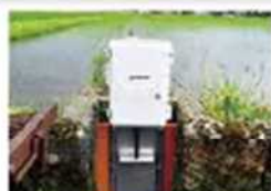
ICT自動給水栓等の設置
