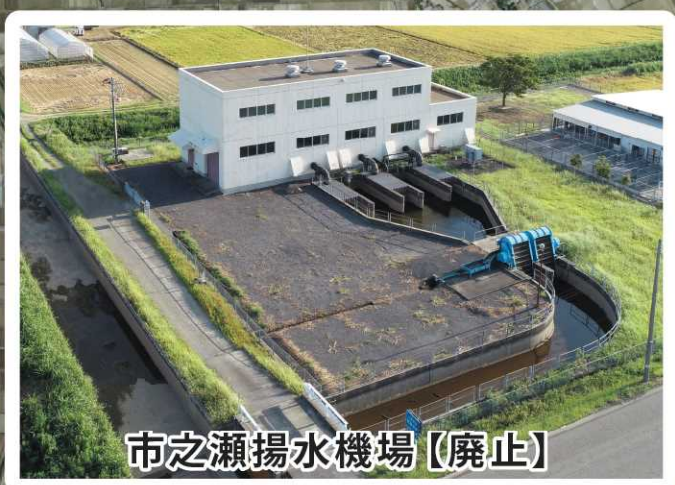
車場揚水機場【改修】
