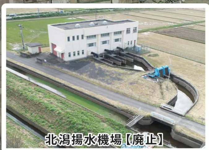
市之瀬揚水機場【廃止】
