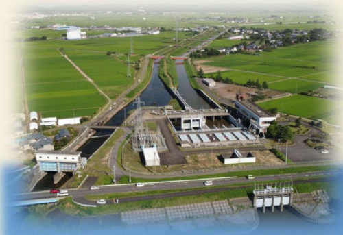
大秋排水機場
