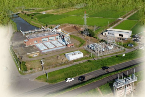
覚路津排水機場
