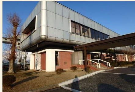
大秋排水機場建屋現況
