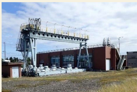
覚路津排水機場建屋現況
