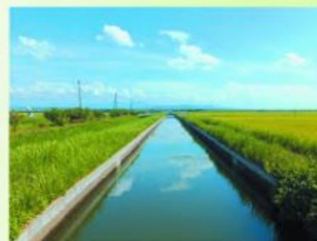
車場幹線用水路
