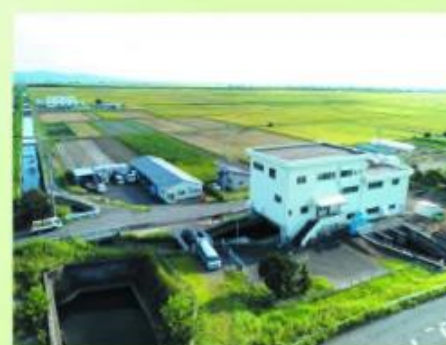
車場揚水機場
