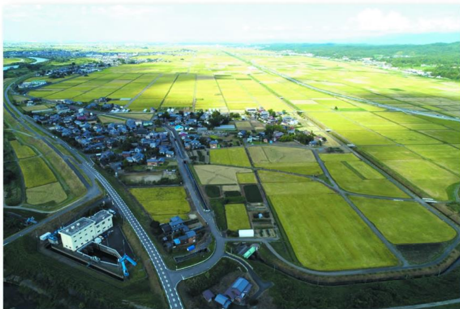
水田揚水機場より受益地を望む（左下：水田揚水機場）
