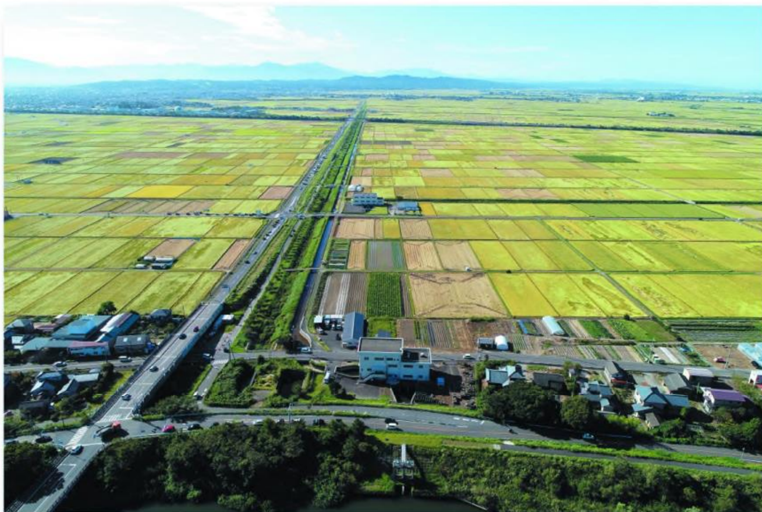
車場揚水機場より受益地を望む（中央下：車場揚水機場）
