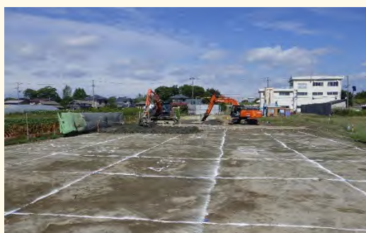
【令和 6 年 10 月 地盤改良】
