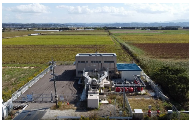
干拓地と揚水機場
