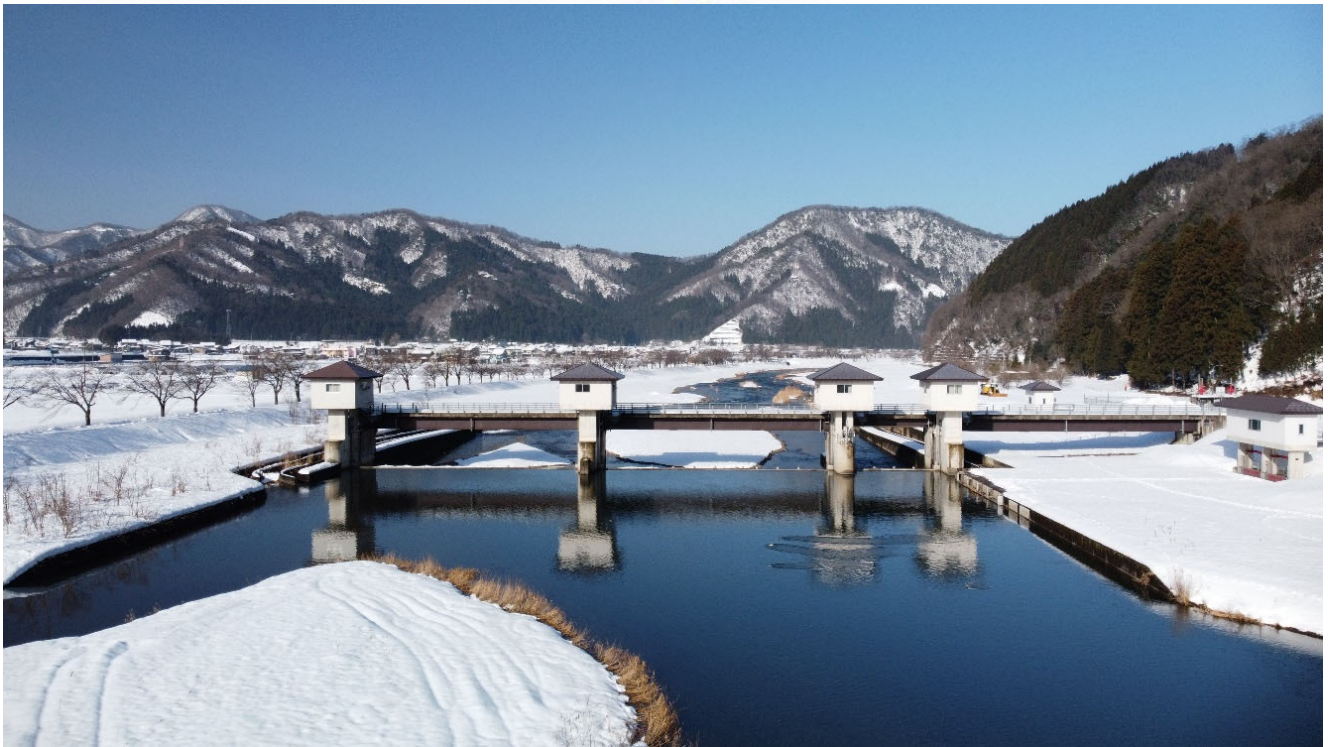
八乙女頭首工（福井県越前市）
