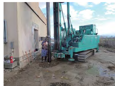
杭施工 (羽根付鋼管杭 φ216.3 L=19.0m)
