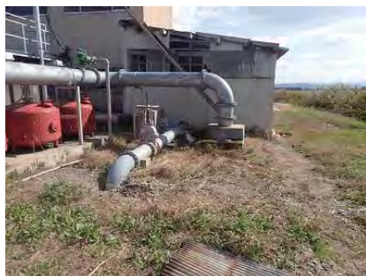
圧力タンク小屋・配管改修前
