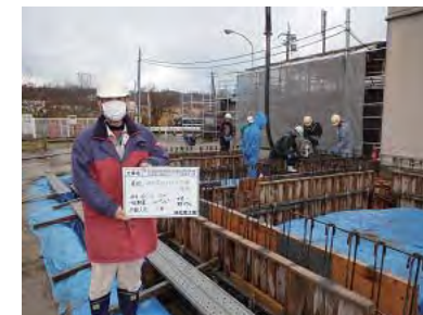
圧力タンク上屋施工中 (鉄骨造平屋建)
