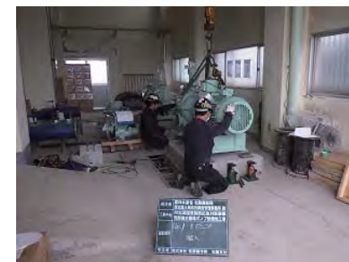
主ポンプ据付 (φ250横軸両吸込渦巻ポンプ)
