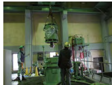
電動機取外し中
