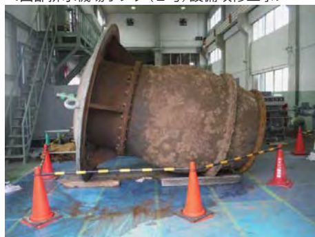
ポンプ取外し
