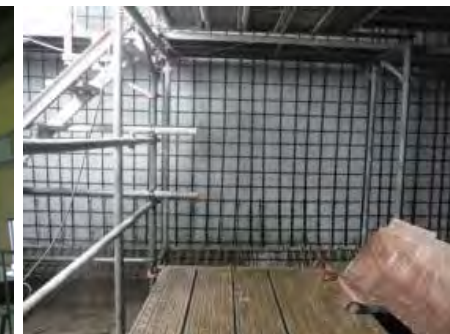
補強鉄筋組立
