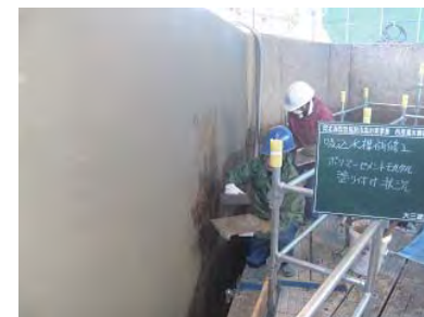
ポリマーセメント施工
