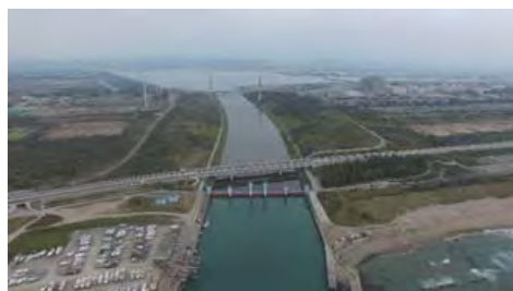
放水路及び防潮水門
