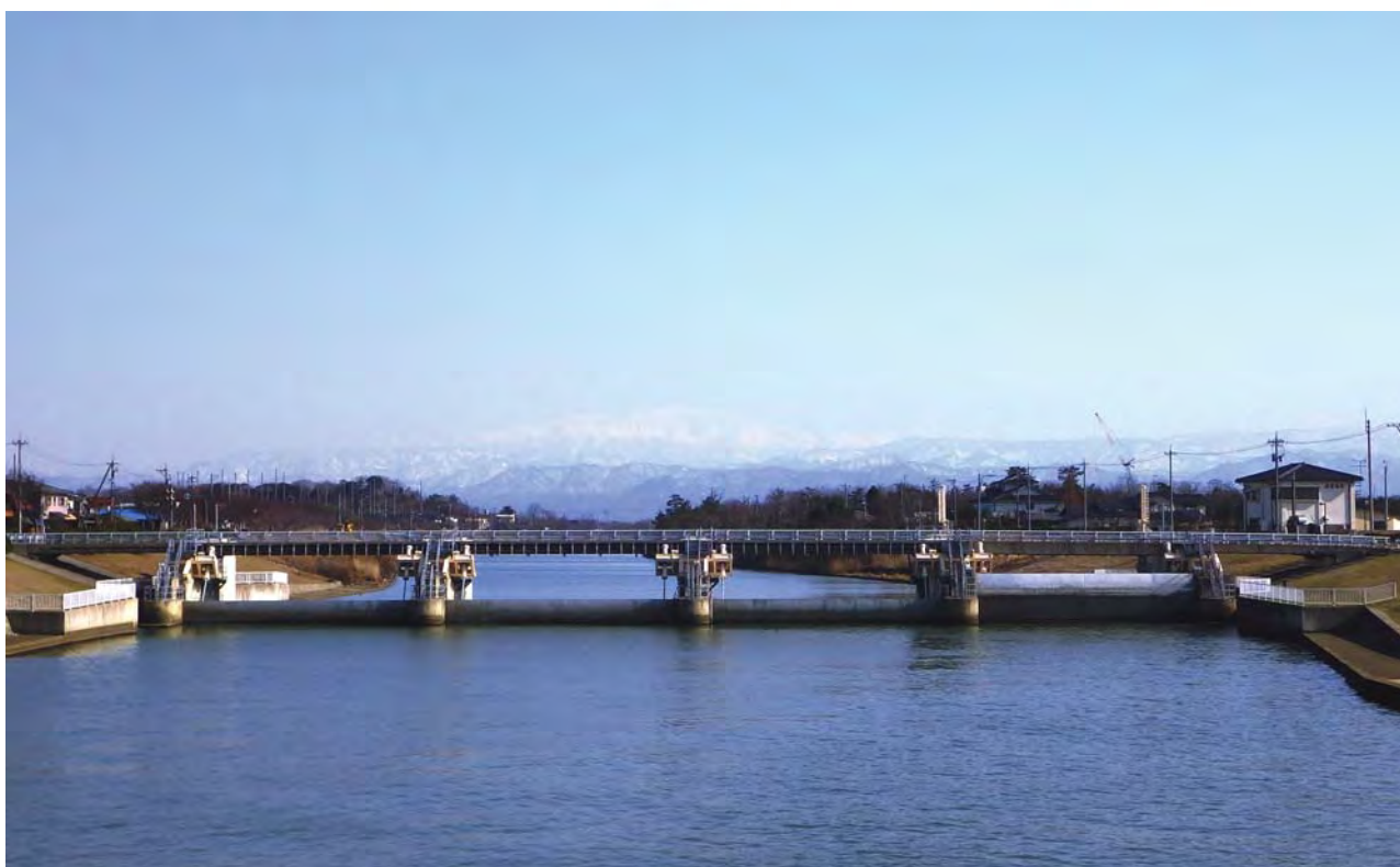
新堀川潮止水門（石川県加賀市）
