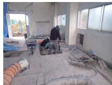
ポンプ基礎撤去
