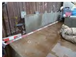
取付金具とパネル設置状況
