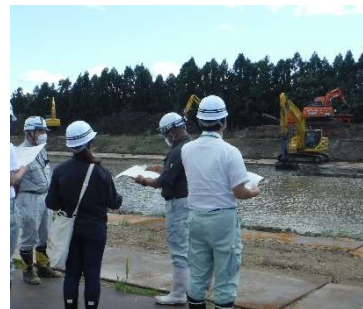
ICT建設機械による施工 (河北潟農地防災事業所)
