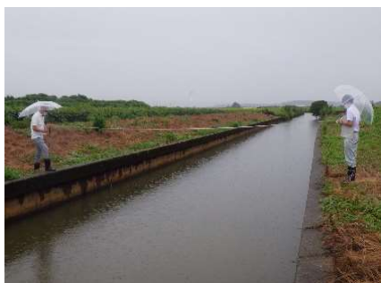
施設の劣化状況調査 (柴山潟幹線水路)
