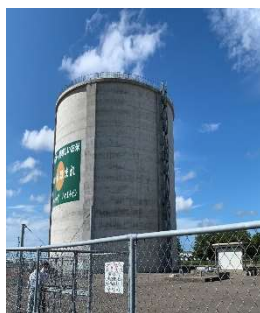
基幹水利施設の視察 (十郷調圧水槽)
