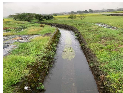
環境配慮水路 (富山市内の農業用排水路)
