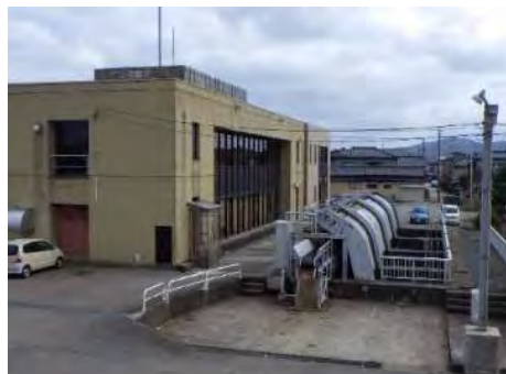
十二町潟排水機場 業務紹介
