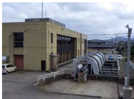
十二町潟排水機場 業務紹介
