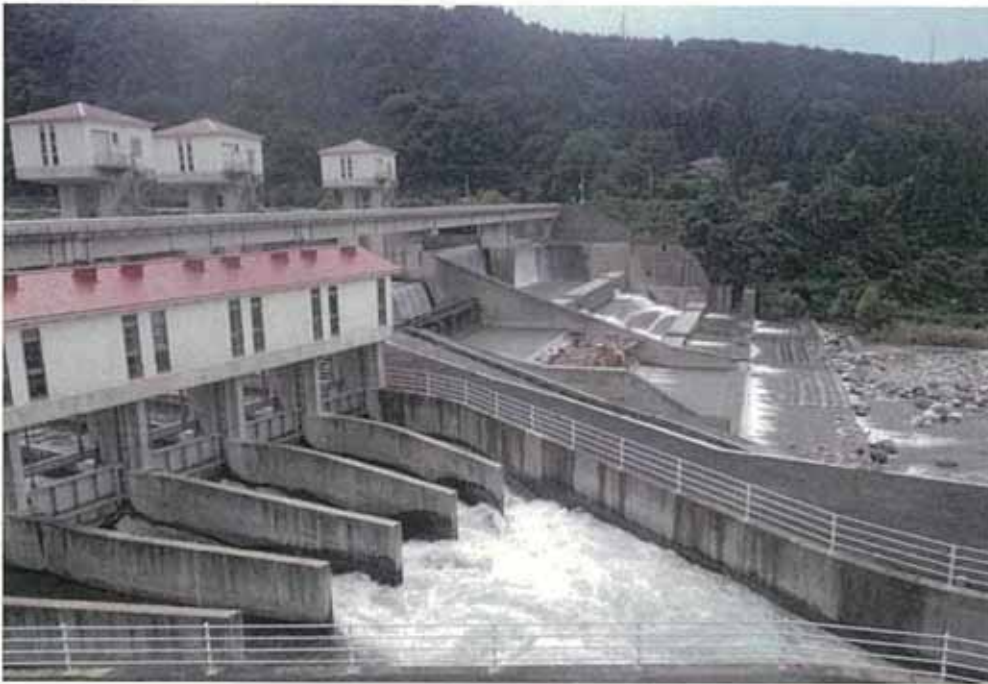
国営常願寺川沿岸地区 横江頭首工（富山県立山町）
