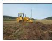
傾斜均平施工
