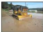
水整地による均平化施工 (湛水状態で整地)
