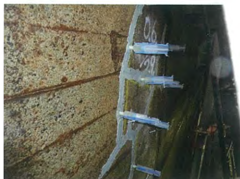
吸水槽劣化補修（ひび割れ充填）
