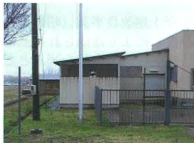
圧力タンク上屋改修前
