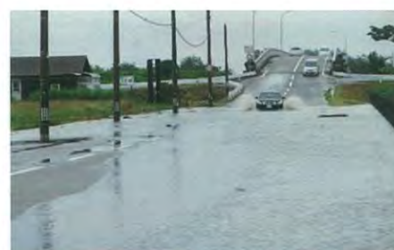
周辺道路の冠水状況（H29.7）
