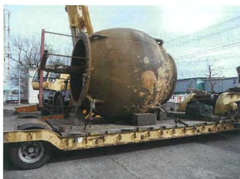
1号ポンプ搬出
