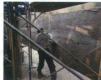
吸水槽表面補修状況
