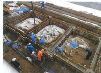
地中梁コンクリート打設
