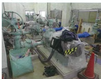
主ポンプ据付状況（φ200 横軸両吸込渦巻ポンプ）
