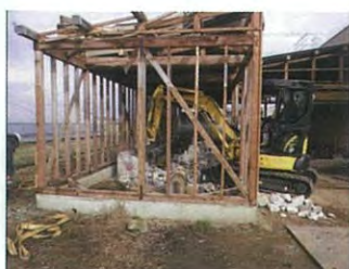
既設上屋撤去工（木造）
