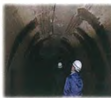
トンネル内部
