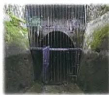
トンネル入口
