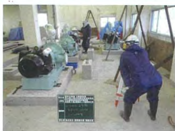
主ポンプ据付状況（φ200 横軸両吸込渦巻ポンプ）
