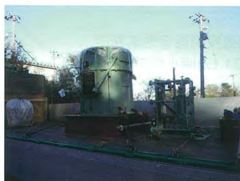
3号ポンプ減速機搬出
