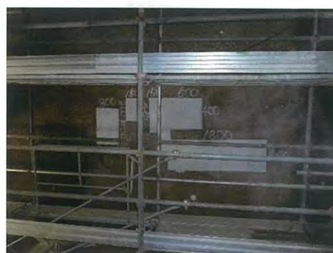
吸水槽劣化補修（欠損部分補修）
