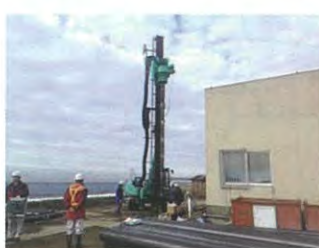
基礎杭施工 （羽根付鋼管杭 L=25.0m）
