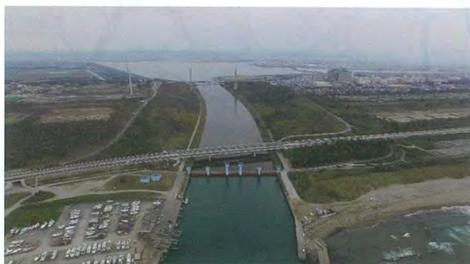
改修を待つ河北潟防潮水門
