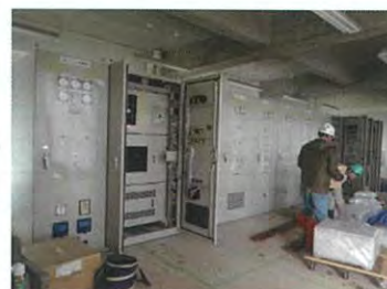
電気盤据付状況
