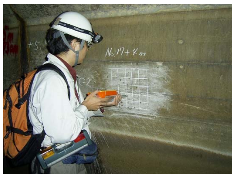
過年度の調査(コンクリート強度試験)
