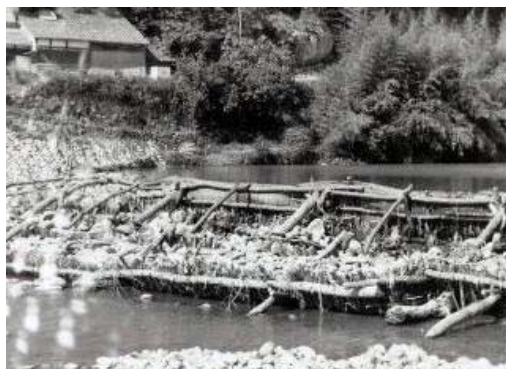
木工沈床により合口された堰
