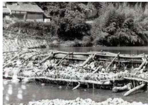
木工沈床により合口された堰
