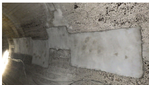
施工完了(断面修復工法)
