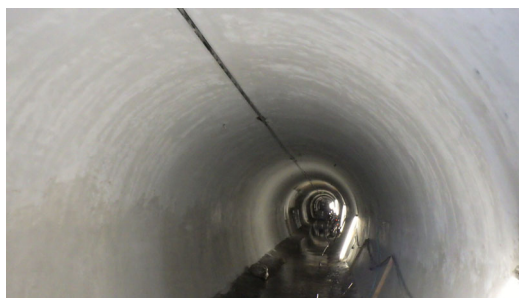
施工完了(FRP格子筋補強工法)
