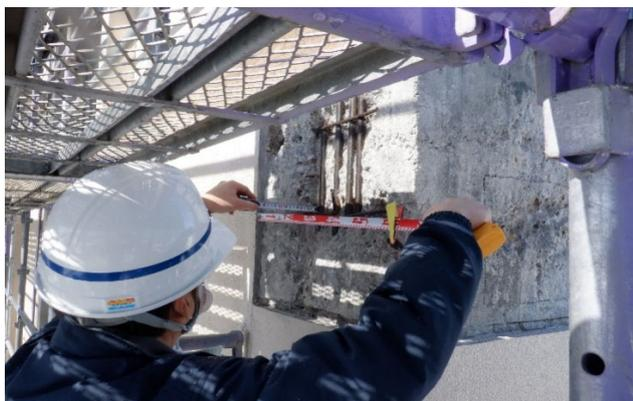
排水機場建屋の工事では、柱の脆弱部を除去した後、無収縮モルタルの充填やポリマーセメントの被覆にて補修。
