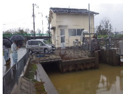
中嶋排水機場
