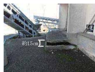
地盤沈下で生じた排水機場建屋入口の段差
