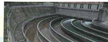
多連化された沈砂池
