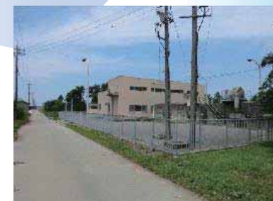
東部第1揚水機場
