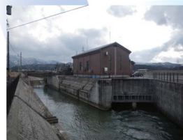
七ヶ用水発電所(水路式発電) 最大出力:630kw 平成16年4月運転開始
