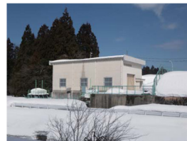
愛本新発電所(水路式発電) 最大出力:530kw 平成元年12月運転開始
