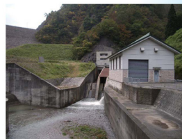
白中発電所(ダム式発電) 最大出力:910kw 平成10年12月運転開始
