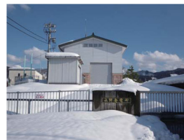
示野発電所(水路式発電) 最大出力:550kw 平成11年1月運転開始
