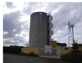
上郷発電所(水路式発電) 最大出力:640kw 平成7年4月運転開始
