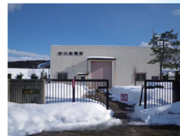
安川発電所(水路式発電) 最大出力:640kw 昭和62年12月運転開始
