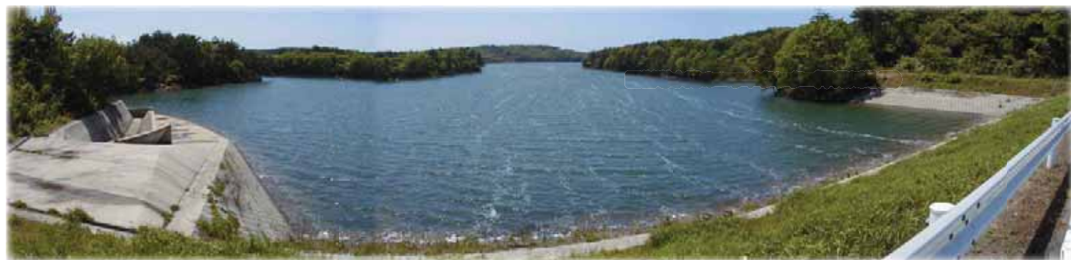
志賀町の国営土田・志賀浦地区で造成した猪之谷ダム全景（昭和31年度竣工）
