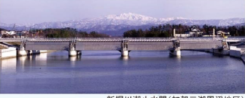
新堀川瀬止水門(加賀三湖周辺地区)
