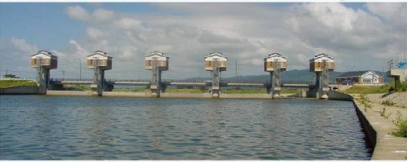
羽咋川瀬止水門(邑知地溝帯地区)
