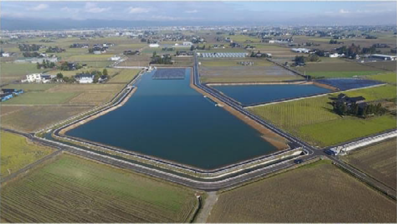
岸渡洪水調整池(庄川左岸地区)
