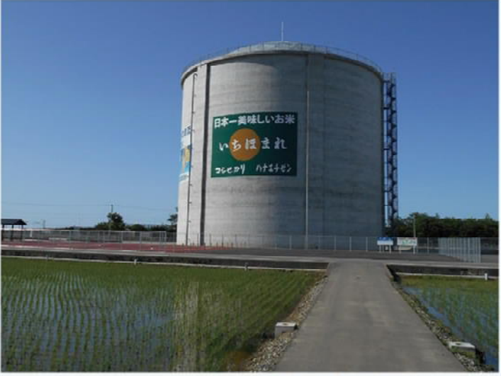
十郷調圧水槽(九頭竜川下流地区)
