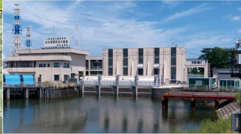
東部排水機場(射水平野地区)
