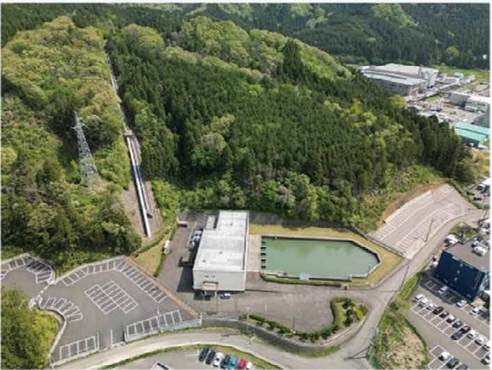
坂井北部丘陵揚水機場(坂井北部地区)
