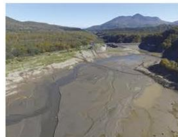
貯水池内の堆砂(真川筋)
