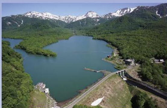
農業生産を支える笹ヶ峰ダム(乙見湖)
