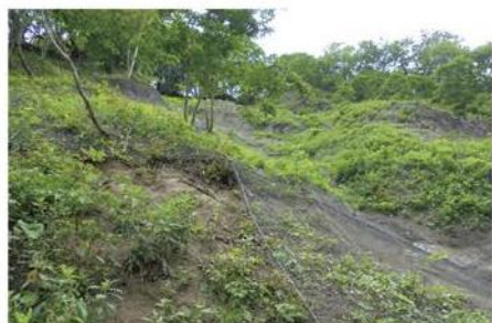
景観色(ダークブラウン)の落石防護網を採用 (副次的に自生種が着床)
