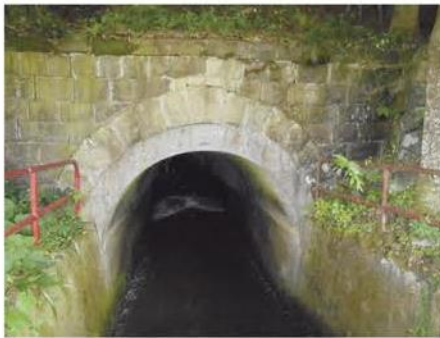
川上トンネル坑口(石積みに変位)
