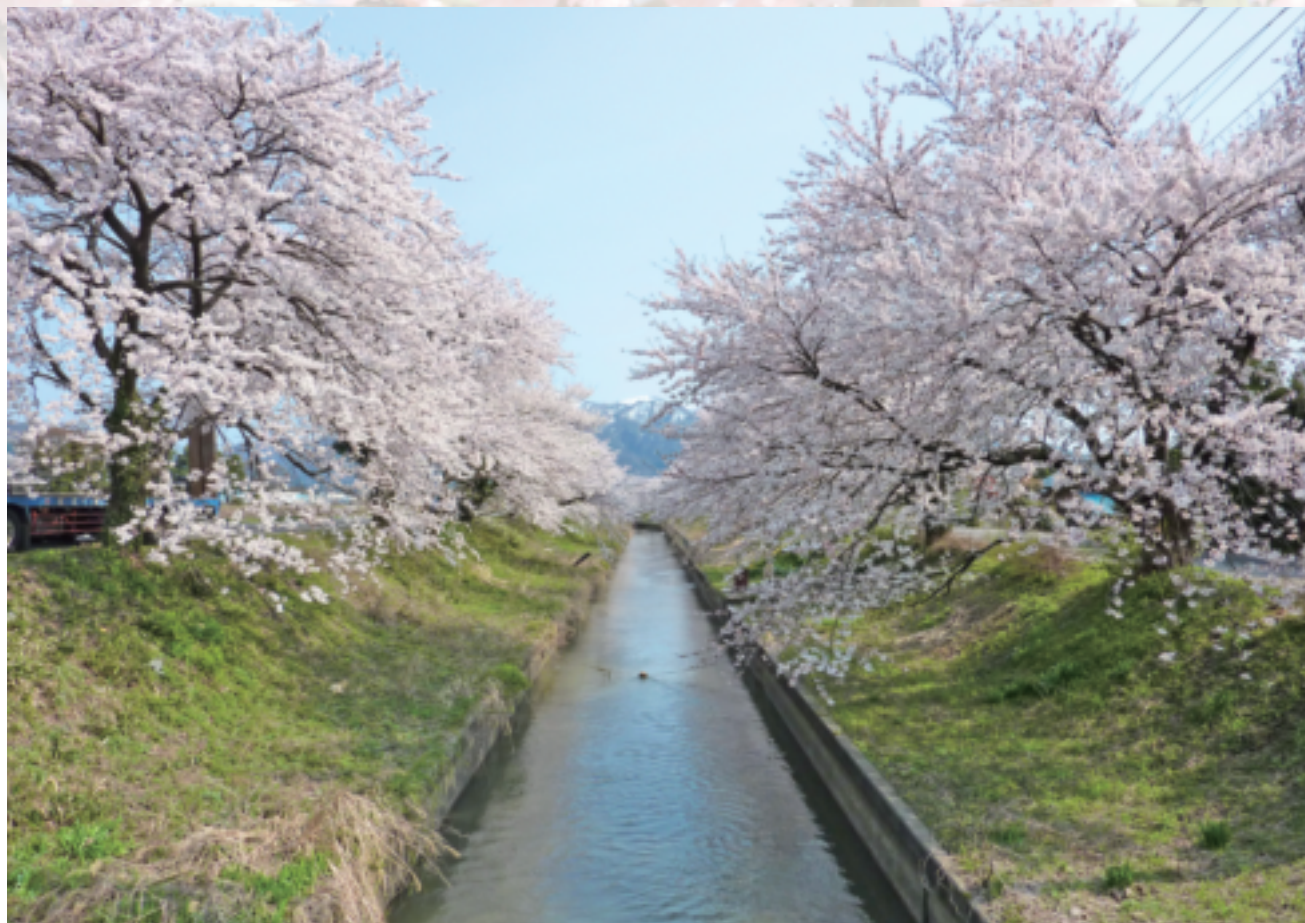
新江幹線用水路 ※阿賀野市
