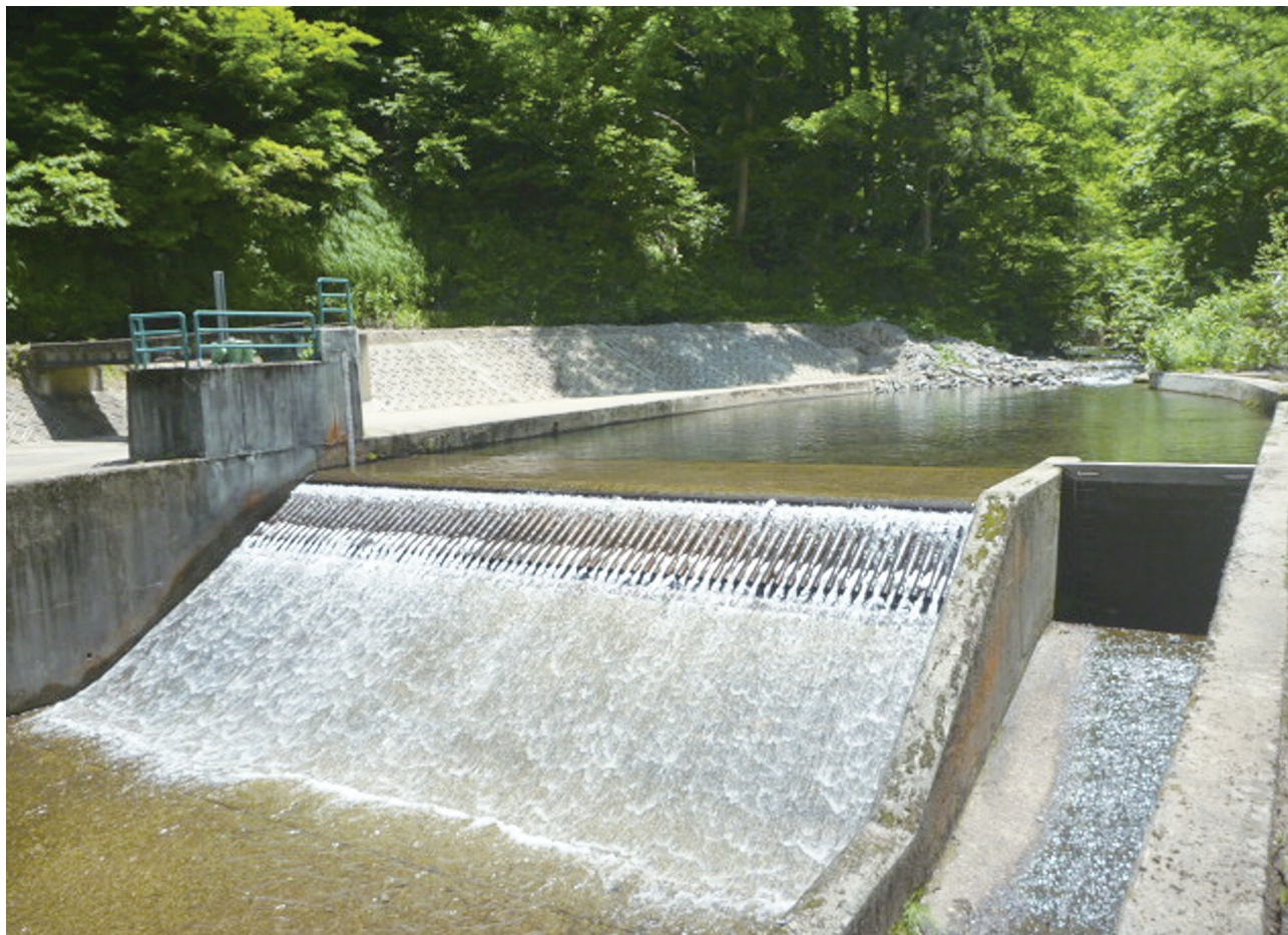
横平川取水工 ※中魚沼郡津南町
