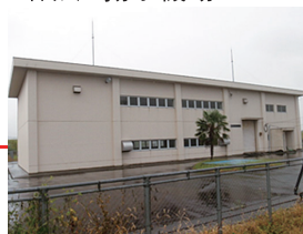
昭和江揚水機場
