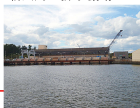
新川河口排水機場
