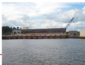
新川河口排水機場
