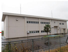
昭和江揚水機場
