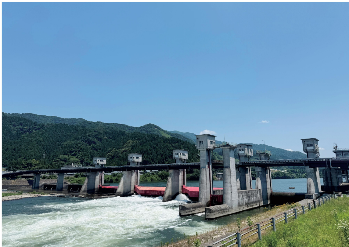
阿賀野川頭首工 (新潟県阿賀野市)
