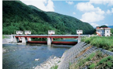
早出川頭首工
