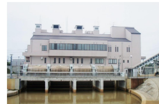
白根排水機場
