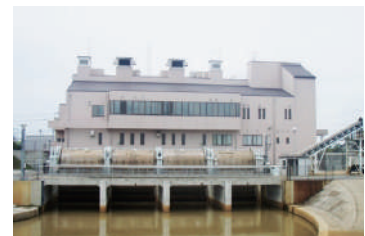
白根排水機場
