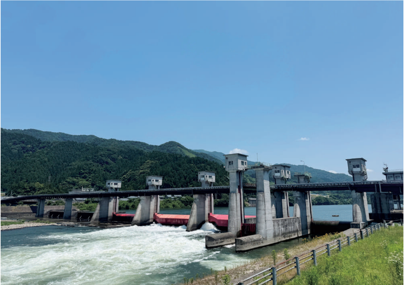
阿賀野川頭首工 (新潟県阿賀野市)
