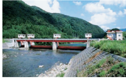
早出川頭首工
