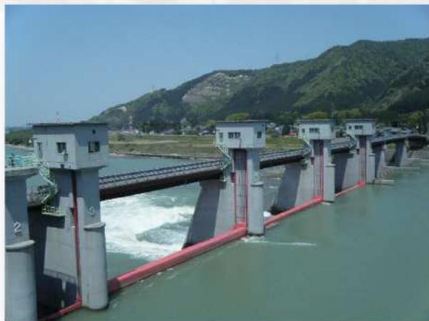
【阿賀野川頭首工】 (上流より臨む)
