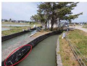
【長浦 1 号水路】 (アルカリ骨材反応)
