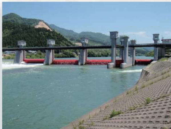
【阿賀野川頭首工】 (下流より臨む)
