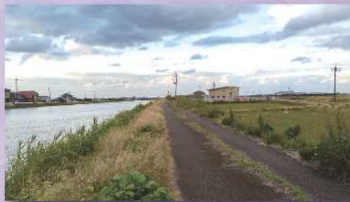
新川の堤防（田潟排水機場付近）から下流側を臨む
