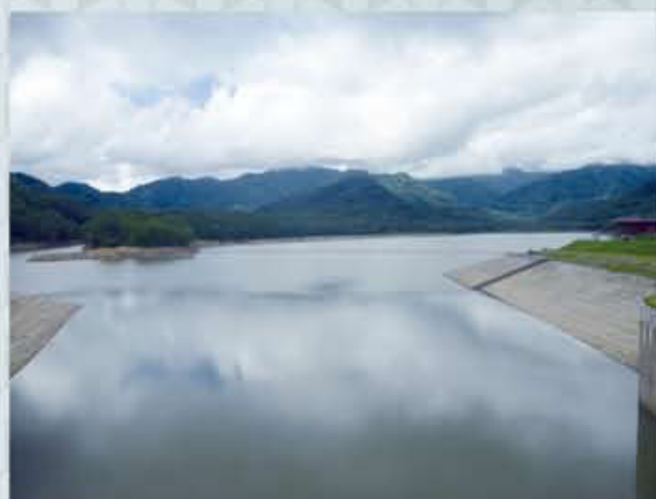
笹ヶ峰ダム堰堤から臨む
