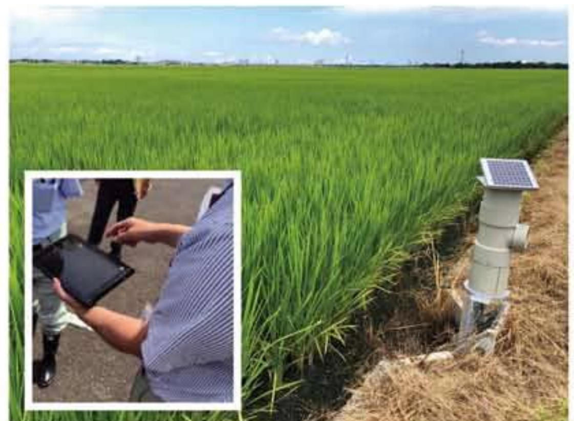
写真1. スマートフォン等により遠隔操作が可能な自動給排水栓が設置されたスマート田んぼダム(新潟市江南区和田地内)
