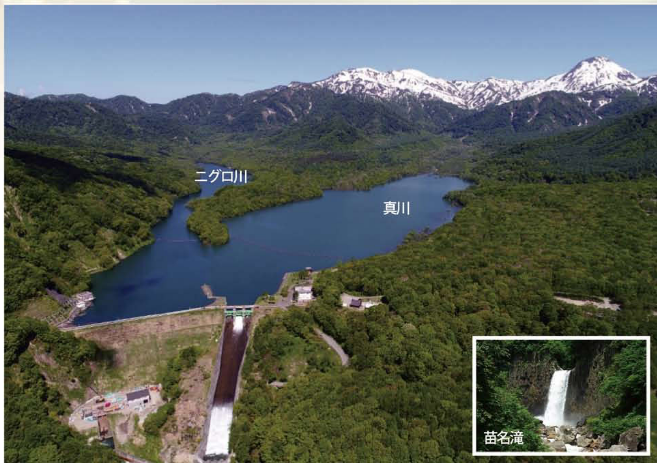
笹ヶ峰ダム ※新潟県妙高市杉野沢
