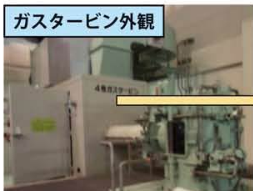
工事後のガスタービン
